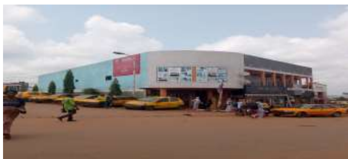
Photo 21 ; gare routière située à MIMBOMAN EST
