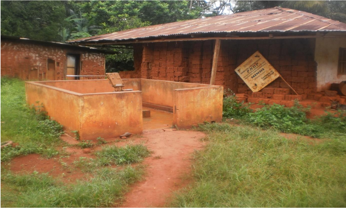
Photo 3 : Forage mal entretenu dans un village
