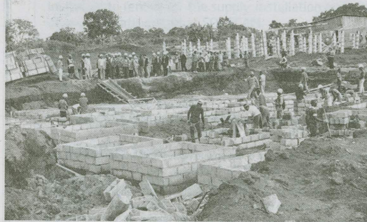
L'accent doit être mis sur la qualité des ouvrages.
