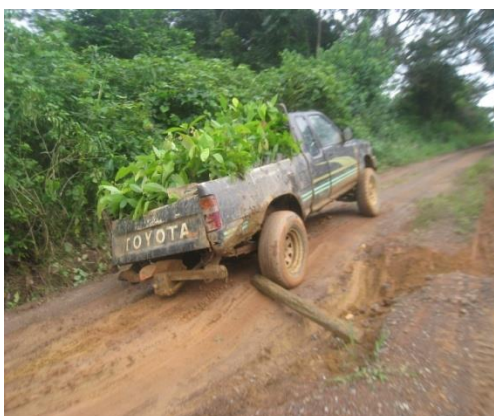
Photo 10: Etat Précaire de la route et ses ravages
