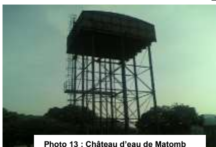
Photo 13 : Château d'eau de Matomb
