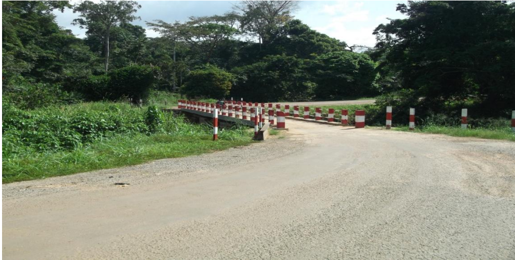
Photo 2 : Pont sur la Ngobo renové sur l'axe bitumé Yaoundé-Okola-Evodoula
