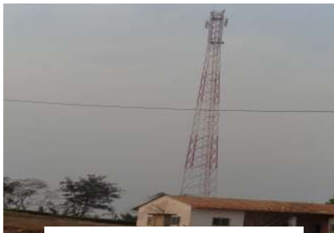
Photo 17: Antenne de téléphonie installée à Dzeng Ville
